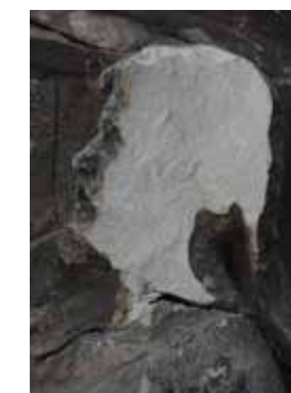
Silne ubytki formy rzeźbiarskiej detalu, (fot. P. Krupa, 2017)
