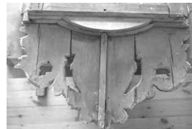
Konstrukcja ramy lustra, (fot. Mateusz Bień)
